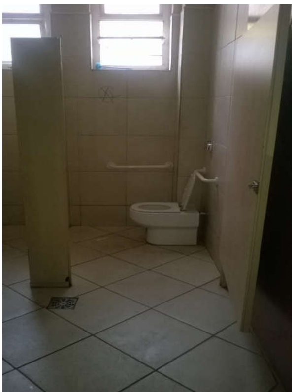
IMAGEM 12 – Box acessível no Sanitário Térreo. Fonte: Edinei Barros 20/01/2016.
