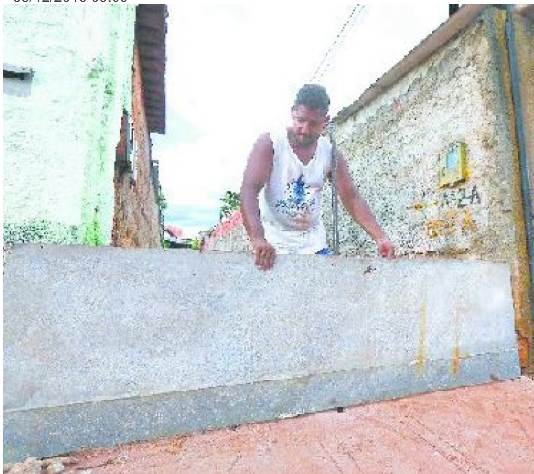
Johnatan Moraes coloca placa de metal por onde entra água na casa
